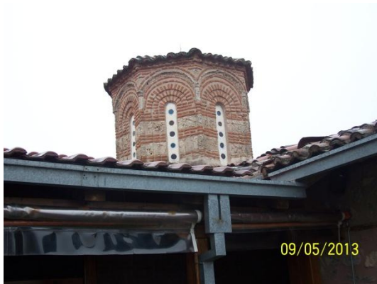
Vse fasade so zgrajene iz opeke
